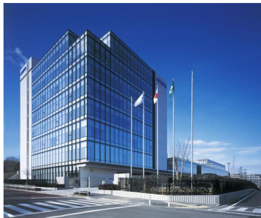
《JUKI本社ビル外観》
