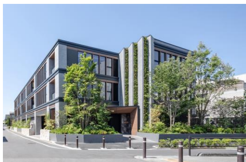
マンション竣工時の植栽
