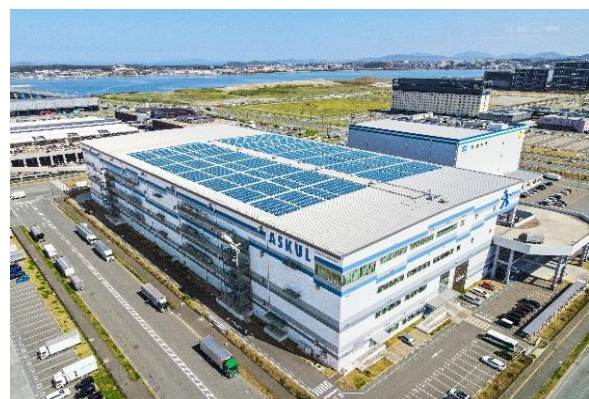
リエネ LOGI'Q 福岡太陽光発電所 （本セミナーで紹介した東急不動産の太陽光発電事業事例）
