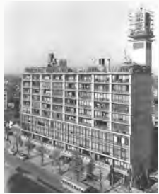
東急スカイライン (分譲集合住宅)
