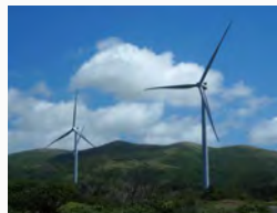
リエネ松前風力発電所
