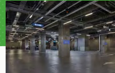
周辺道路の路上荷捌きの渋滞解消に貢献した地域荷捌き駐車場「ESSA」。地元等と連携して協議会も設立
